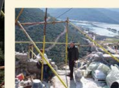
Radnik na obnovi zidova u Dubrovniku, foto: Miroslav J. J. / Miroslav J. J., 2019.
