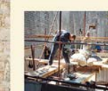
Radnik na obnovi zidova u Dubrovniku, foto: Miroslav J. J. / Miroslav J. J., 2019.
