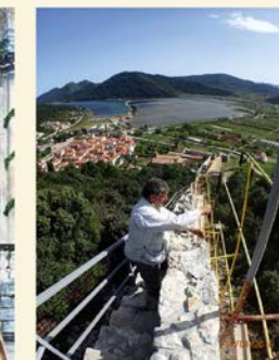
Radnik na obnovi zidova u Dubrovniku, foto: Miroslav J. J. / Miroslav J. J., 2019.
