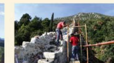
Radnik na obnovi zidova u Dubrovniku, foto: Miroslav J. J. / Miroslav J. J., 2019.
